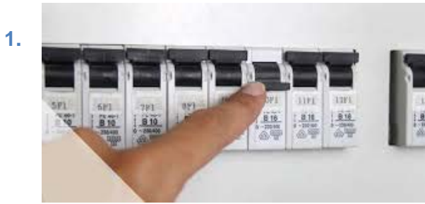
插图 115 : 关断供电
