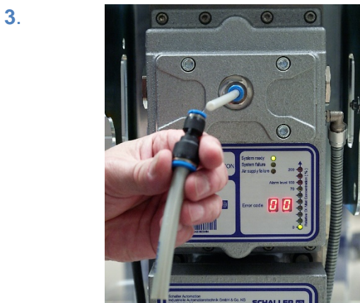
插图 74：安装柔性软管
