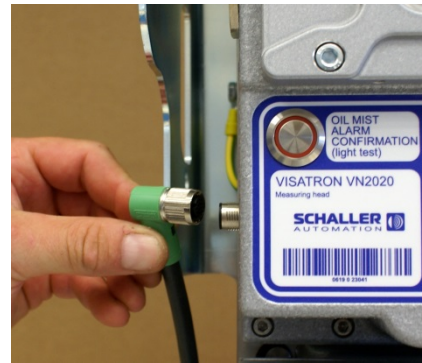
插图 116 : 松开插头连接
