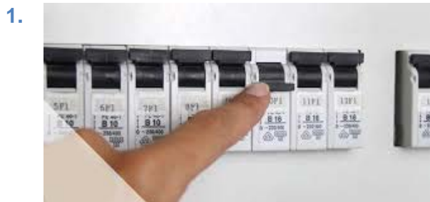
插图 151：关断供电
