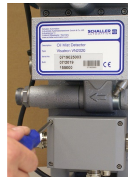
插图 49 : 安装接线盒盖子
