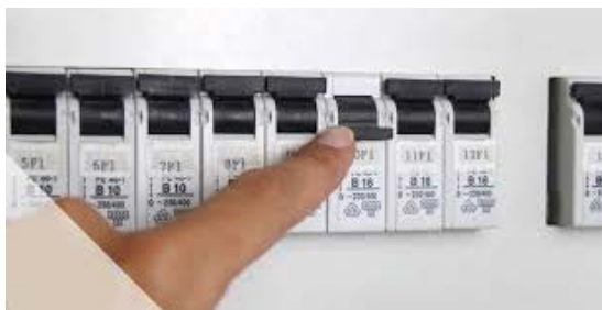
插图 102 : 关闭能量供应
