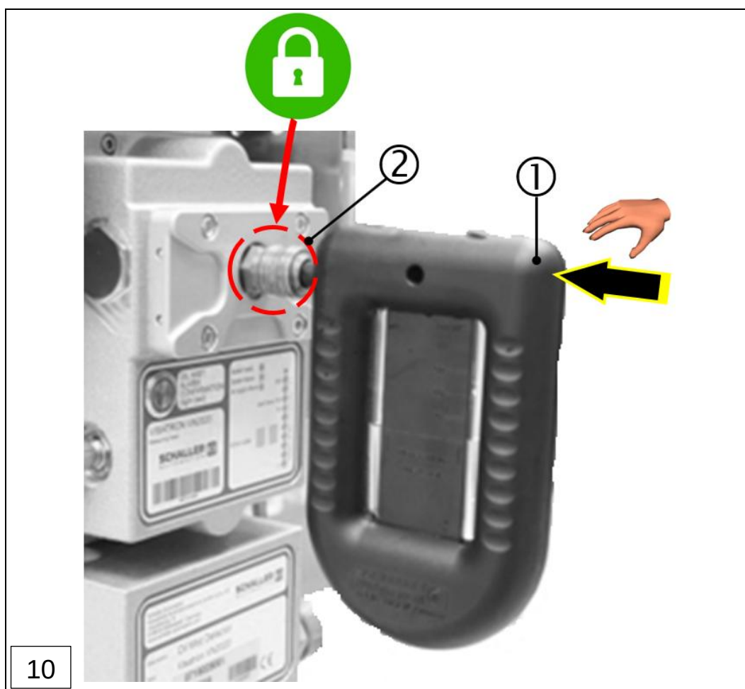
圖: 78: 更换空气滤清器滤芯，压力控制器单元 (步骤 1 - 10)
